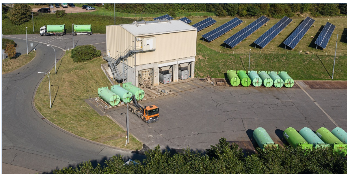
Bild 2: Müllumladestation Niederdorf: Umladung der Restabfälle in Presscontainer für den Transport nach Zorbau, BUR Werbung Annaberg-B., Sept. 2020
